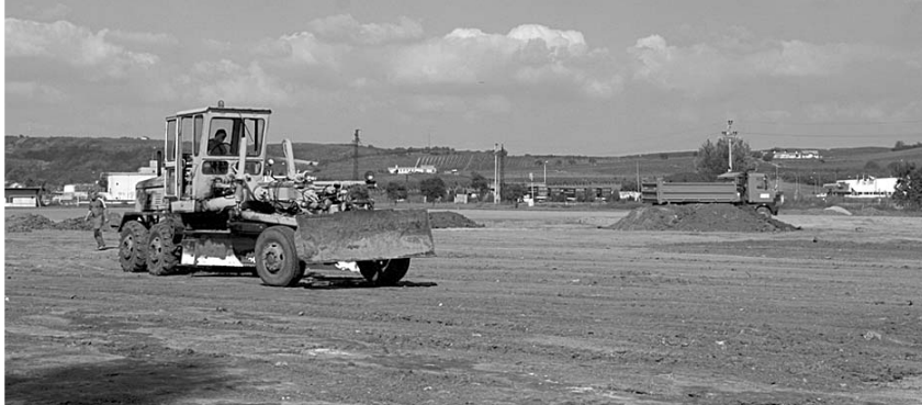
Práce na budování nového fotbalového hřiště – srovnávání terénu a úprava před osetím travním semenem. Foto: Ing. Zdeněk Karber
