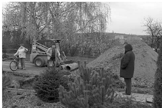
I kanalizace potřebuje opravit. Foto: Ing. Zdeněk Karber
