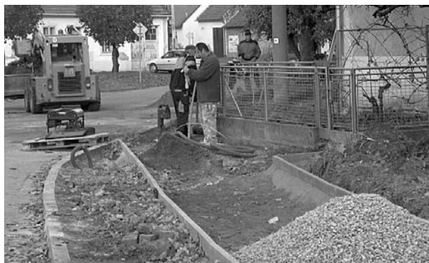
Práce na opravě chodníků – úsek před hasičskou zbrojnicí na Nám. 9. května. Foto: Věra Procingerová
