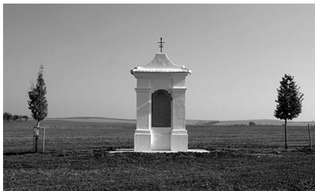
Krásně opravená kaplička na Přičníkách září bílou novotou. Chybí zde jen soška světce. Tě se drobná barokní stavba dočká na jaře roku 2011. Foto: Ing. Zdeněk Karber
